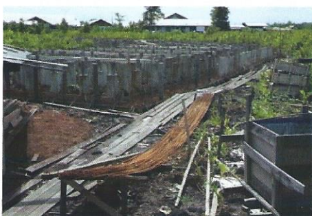
Nieuwe Agats museum in aanbouw. Foto Wim van Oijen
